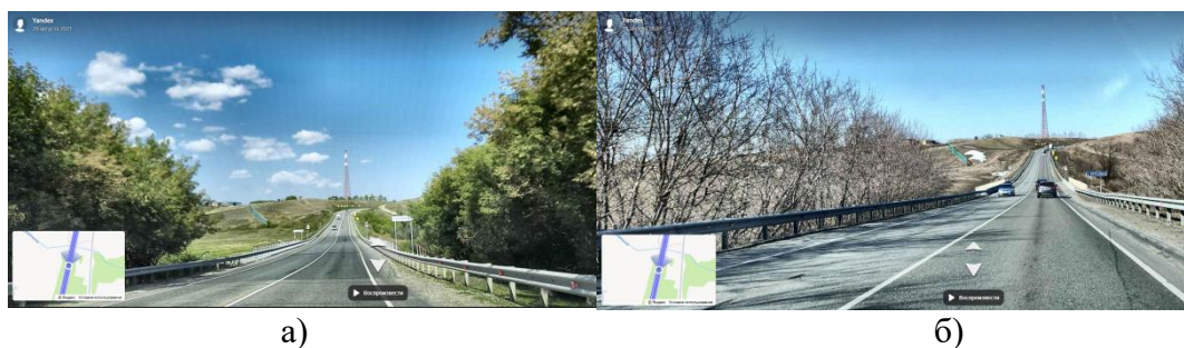
а) до ремонта; б) после ремонта
